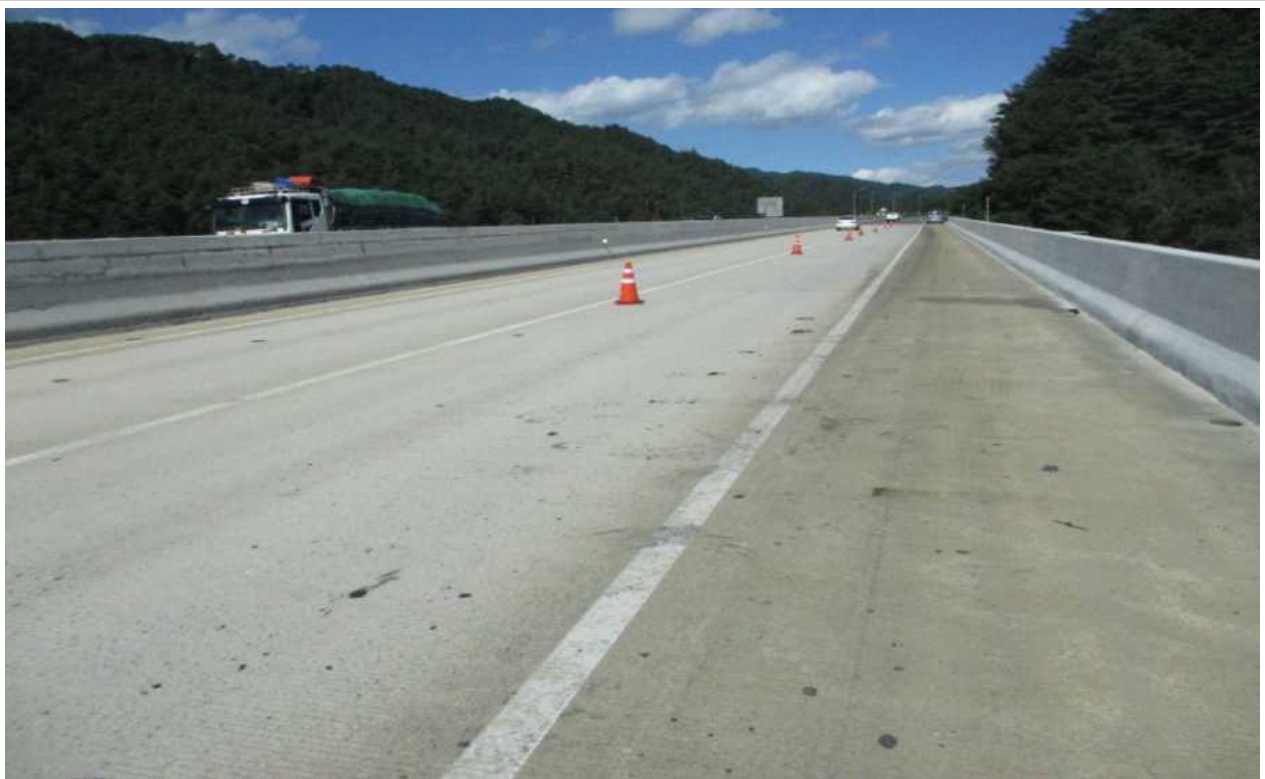
교량 상부 전경
